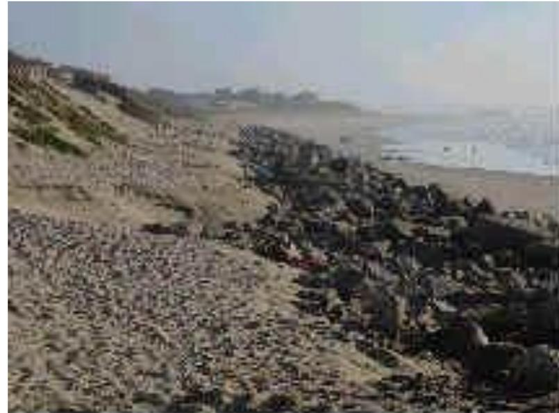
As estruturas paralelas à costa consistem em **enrocamentos**, grande quantidade de enormes blocos rochosos dispostos junto à costa, protegendo-a.
