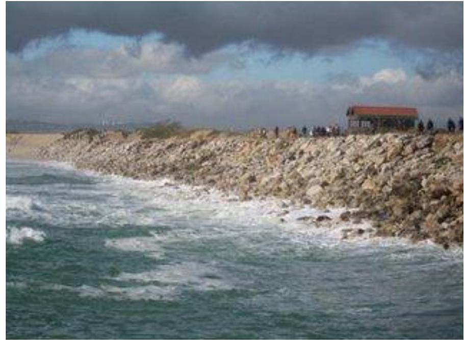
**Os paredões** são estruturas paralelas à linha de costa, que se destinam a evitar o efeito abrasivo sobre a linha de costa.
